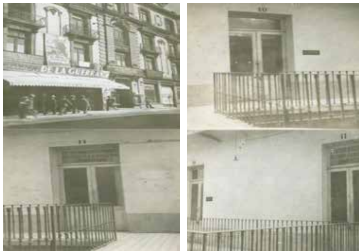
Figura 3.5: Consultorio del Dr. Eduardo Fritsch. Edificio Bustillos en la calle de Tacuba Núm. 78.
