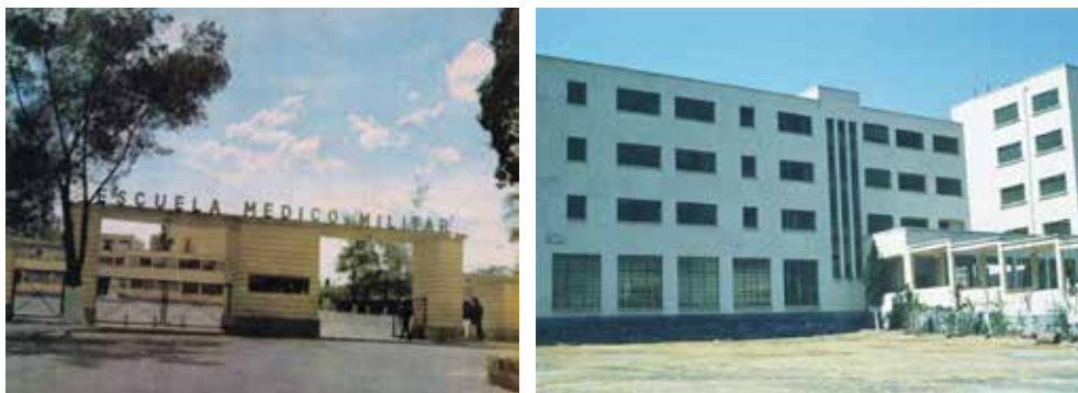
Figura 4.3: Primer edificio de la Escuela Médico Militar en Lomas de Sotelo. A la izquierda se aprecia la fachada principal y a la derecha se muestra el aspecto de edificio posterior con dormitorios y comedor.
