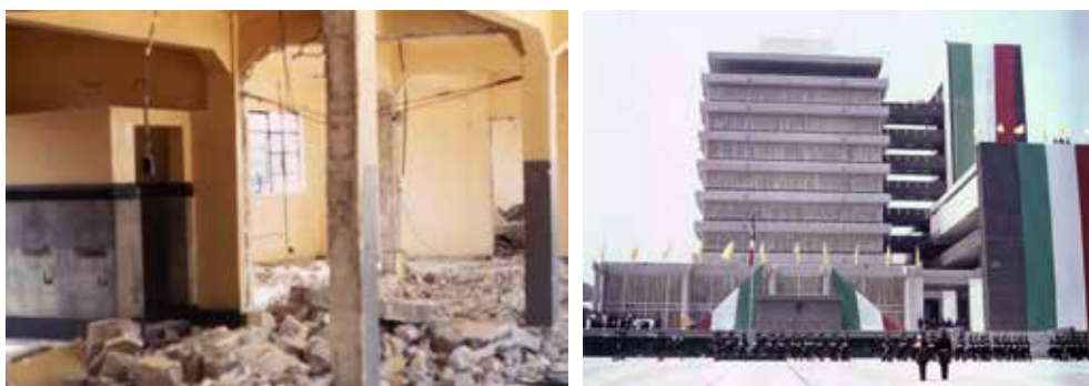
Figura 4.4: A izquierda se muestra imagen de las obras de demolición de edificio original. A la derecha se aprecia imagen del segundo edificio en Lomas de Sotelo.
