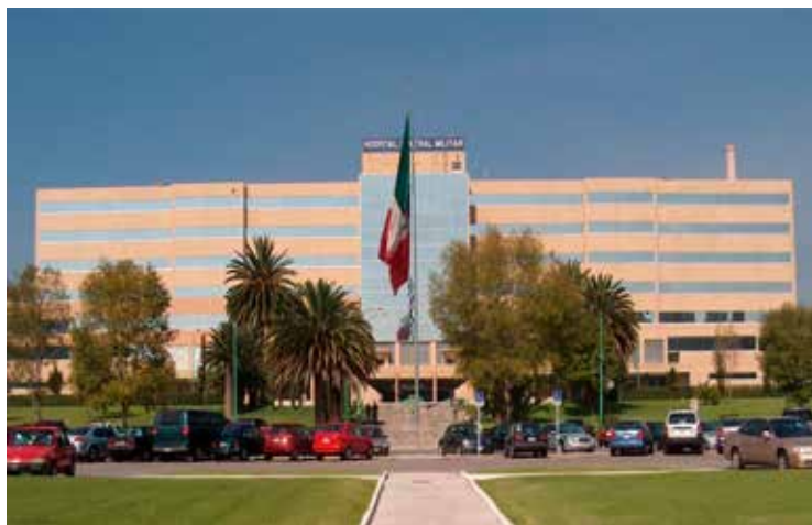
Figura 4.10: Imagen actual del Hospital Central Militar.
