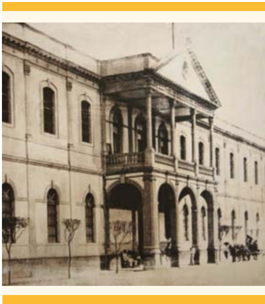
Figura 1. Fachada del Hospital Militar de Instrucción y Escuela Médico Militar en la calle Cacahuatal (1917-1930). Archivo fotográfico de la CEHEMM.
