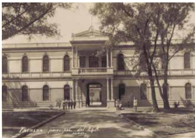
Figura 3.13: Edificio de la Escuela Médico Militar de Arcos de Belén. Archivo fotográfico CEHEMM.
