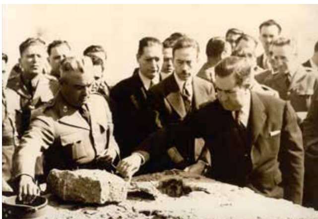
Figura 3.14: Colocación de la primera piedra de la Escuela Médico Militar de Lomas de Sotelo I (1945-1975) por el presidente de la República, Gral. de Div. Manuel Ávila Camacho. Archivo fotográfico CEHEMM.
